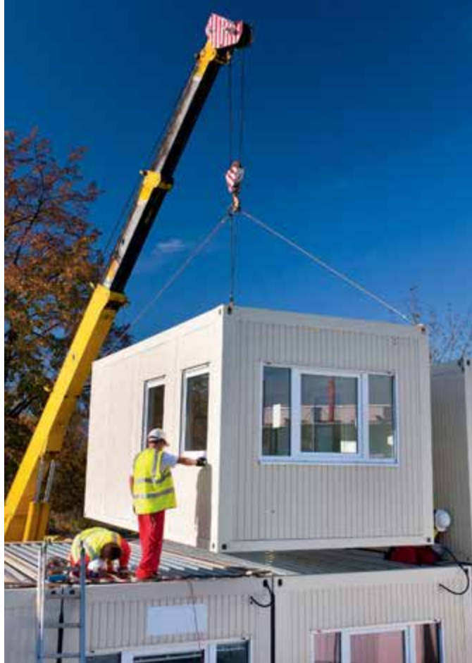
Bei Containern ist beileibe nicht nach einem Stockwerk Schluss. Die Module lassen sich stapeln. Foto: © Martin Bilek/shutterstock.com
