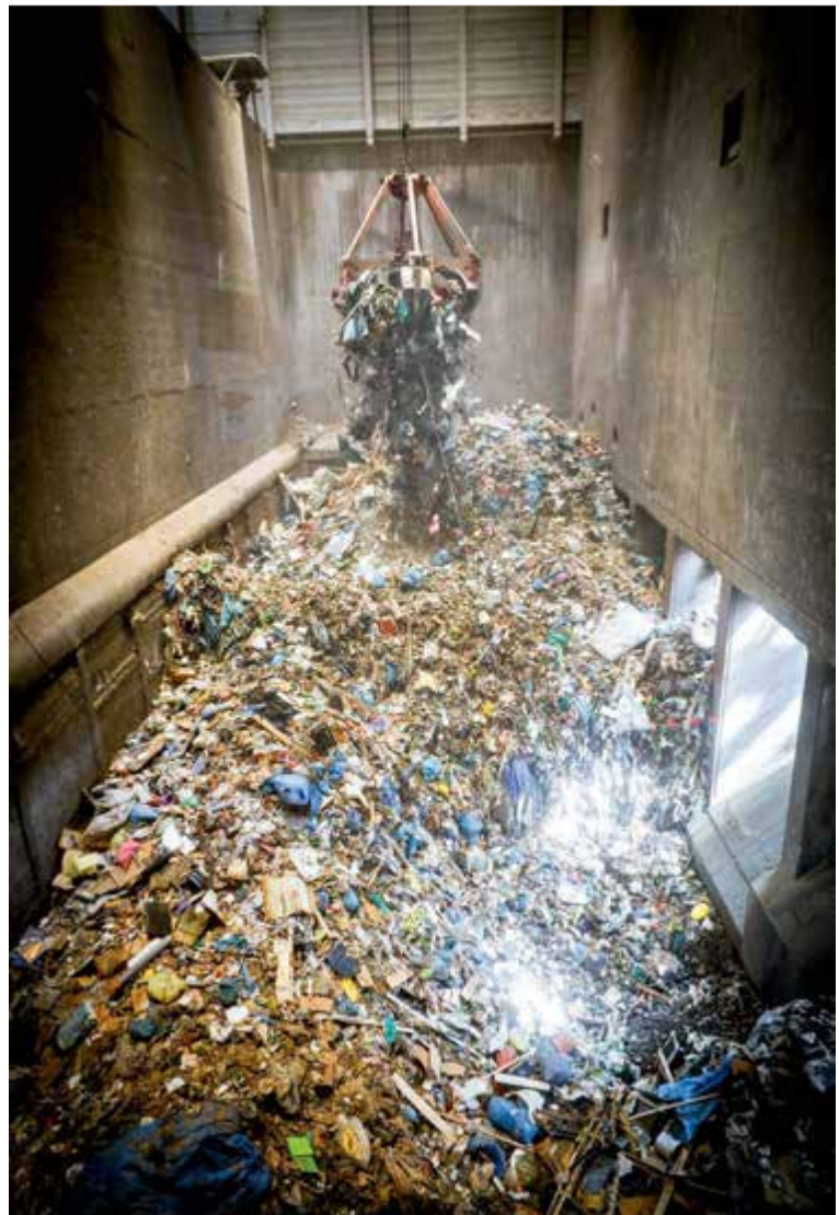
Was nicht recycelt wird kommt ins Heizkraftwerk. Foto: Matthias Kessler
